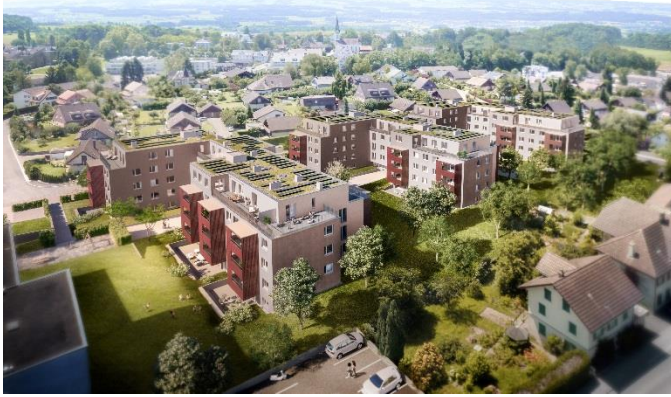
Illustration 11 : Lotissement Sentmatt, Obfelden (ZH) : L'électricité issue des capteurs hybrides est utilisée pour le fonctionnement de la pompe à chaleur et pour l'électricité des parties communes dans le cadre de la consommation propre. Source de l'illustration : Halter Immobilien AG
